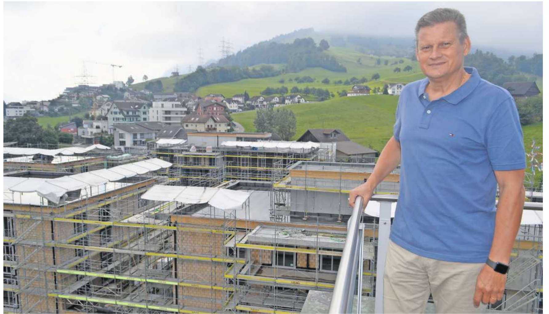
Patrice Riedo, Geschäftsführer und Generalökonom des Vereins Missionshaus Bethlehem, vor der Baustelle in Immensee.
