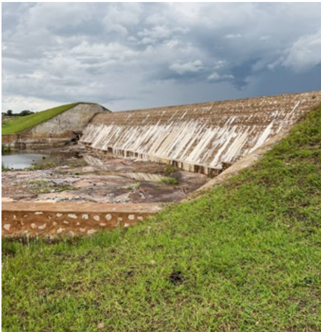
Der grosse Damm wurde komplett saniert und renoviert.
