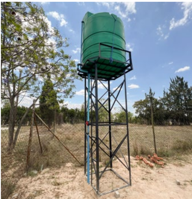
Der Brunnen verschafft der Kirche St. Michael sowie der umliegenden ländlichen Gemeinde Zugang zu Wasser.
