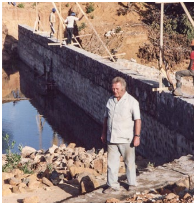
Das Errichten von lokalen Dämmen wurde möglich dank Spenden aus der Schweiz. Im Hintergrund die Bauleute.
