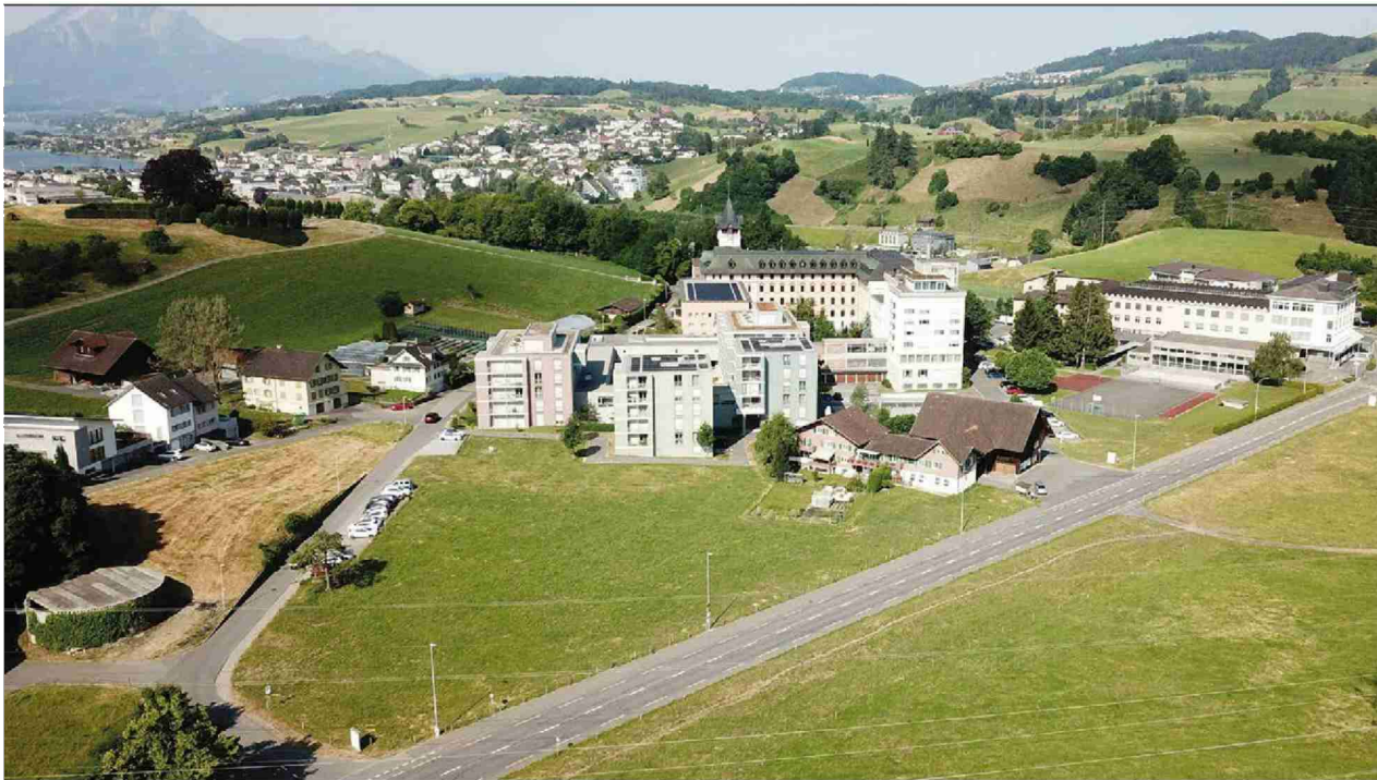
Im Dreieck zwischen Artherstrasse und Bethlehem sollen in den nächsten zwei Jahren vier weitere Wohnhäuser entstehen.
