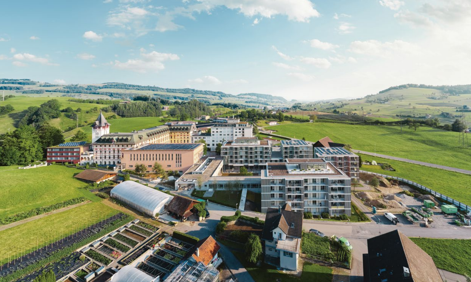
Die Mehrgenerationensiedlung «Im Bethlehem» während der Bauarbeiten. Die ersten Mieterinnen und Mieter sind Anfang 2021 eingezogen.
