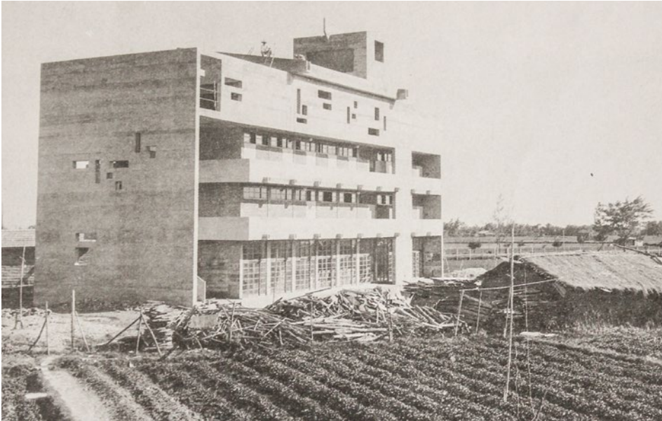
Das Hauptgebäude der Handwerkerschule in Taitung, das sich mitten in den Reisfeldern befindet.
